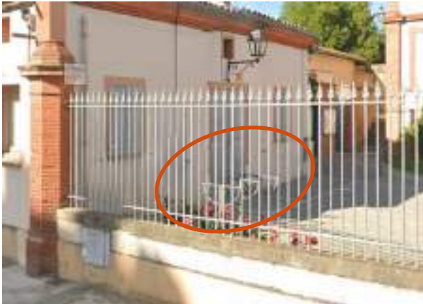
Enceinte de la mairie
