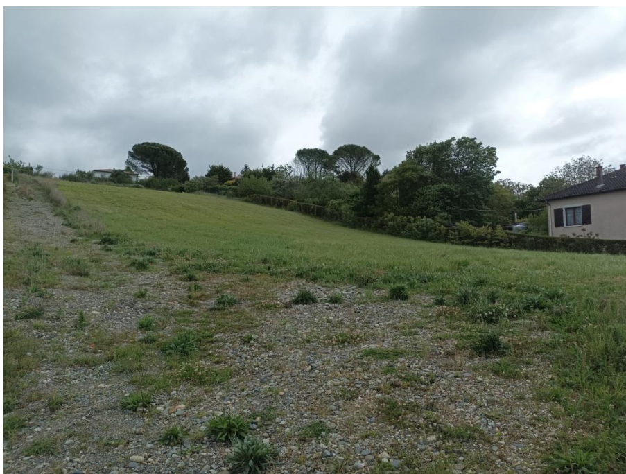
Fig. 9. Vue générale du site 4 depuis le Sud-Ouest
